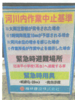
【河川内作業中止基準の掲示板】
