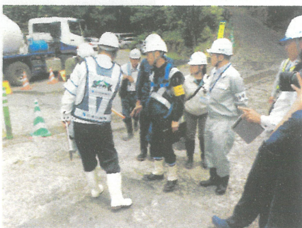
【現場でのパトロールの様子】
